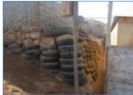
Casas construidas sobre bolsas de cemento relleno de material de la zona, llantas y piedras
