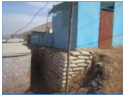
Casas construidas sobre bolsas de cemento relleno de material de la zona, llantas y piedras
