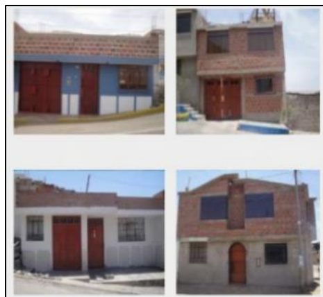
Viviendas construidas con ladrillo
